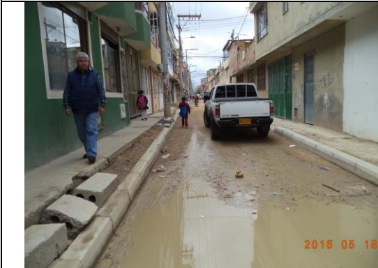
Foto No 5. Localización: Calle 136 A entre Carrera 153 A y Carrera 156 B CIV's 10003857- 11004050-10004086 Estado: Sin terminar Tipo de intervención: rajón, sub-base y base. Segmentos viales sin terminar, quedaron a nivel de base y no se colocó la carpeta asfáltica. Se observa el aposamiento de agua frente al predio identificado con la nomenclatura 136-36, lo que ocasiona daños en la estructura del pavimento. Consecutivo del listado de CIV's intervenidos: No 30,36 y 37
