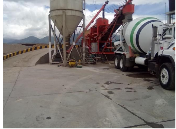
Foto No. 4 Se observa la dosificadora de concreto con la mixer.
