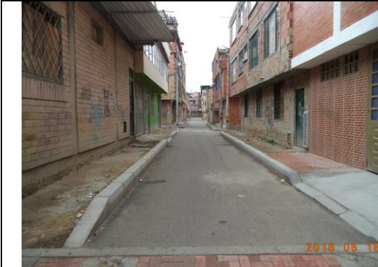
Foto No 7 Localización: Calle 138A entre Carrera 145 y Carrera 147B Bis CIV's 11002768-11002778-11002795-11011954 y 11011952 Estado: Pavimentado Tipo de intervención: geo celda, sub-base, base y pavimento. De acuerdo a la inspección ocular el pavimento se encuentra en buen estado. Consecutivo del listado de CIV's intervenidos: No 43,44,45,46 y 47
