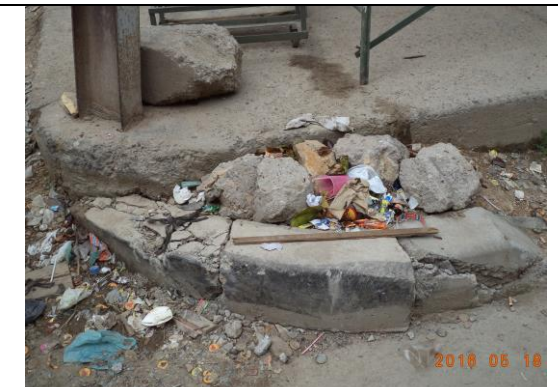
Foto No 13. Localización: Carrera 145 entre calle 138 A y 139 CIV's 11003224-1003160-11003114-11002998-11011957-11002898-11002815 y 11002761. Estado: Pavimentado. Tipo de intervención: geo celda, sub-base, base y pavimento. En algunos sectores los bordillos instalados se encuentran totalmente fracturados y destruidos. Consecutivo del listado de CIV's intervenidos: No 49,50,51,52,53,54,55 y 56
