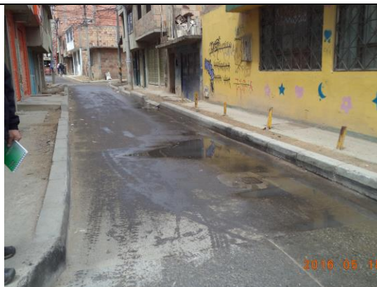
Foto No 12. Localización: Carrera 145 entre calle 138 A y 139 CIV's 11003224-1003160-11003114-11002998-11011957-11002898-11002815 y 11002761. Estado: Pavimentado. Tipo de intervención: geo celda, sub-base, base y pavimento. Se observa aposamientos de agua en la vía, que con el tiempo producen daños en el pavimento. Consecutivo del listado de CIV's intervenidos: No 49,50,51,52,53,54,55 y 56
