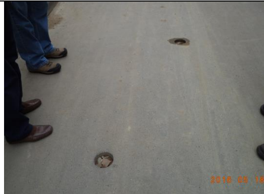
Foto No 6. Localización: Calle 138A entre Carrera 145 y Carrera 147B Bis CIV's 11002768-11002778-11002795-11011954 y 11011952 Estado: Pavimentado Tipo de intervención: geo celda, sub-base, base y pavimento. Segmentos viales con presencia de orificios (por la extracción de núcleos) por donde se presentará filtración de aguas lluvias y de escorrentía, lo que ocasionará daños en la estructura del pavimento. Consecutivo del listado de CIV's intervenidos: No 43, 44, 45,46 y 47.
