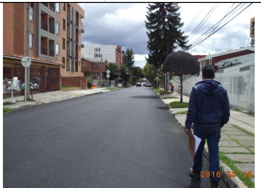
Foto No 14. Localización: Calle 135C entre carrera 9 y 10 A CIV's 1004032- 1004054- 1004067 y 1004086 Estado: Pavimentado Tipo de intervención: fresado, conformación de calzada, pavimento MDC-12 y gránulos de caucho. Se observa el pavimento en buen estado. No se realizó la señalización horizontal ni vertical. Consecutivo del listado de CIV's intervenidos: No aplica
