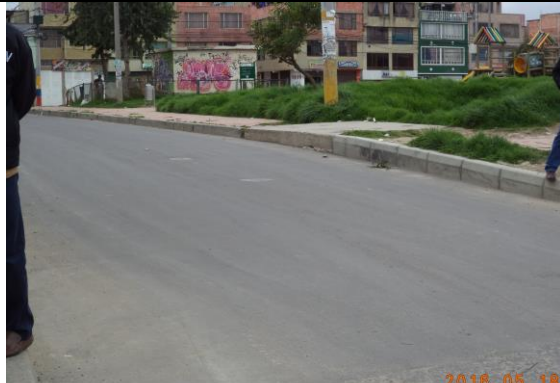
Foto No 8. Localización: Carrera 144 A entre calle 139 a 142 CIV 11002671 Estado: Pavimentado Tipo de intervención: geo celda, sub-base, base y pavimento. De acuerdo a la inspección ocular se observa la vía con ondulamientos Consecutivo del listado de CIV's intervenidos: No 48
