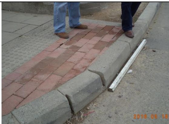
Foto No 11. Localización: Carrera 144 A entre calle 139 a 142 CIV's 11002671 Estado: Pavimentado Tipo de intervención: geo celda, sub-base, base y pavimento. Se observan deficiencias en la instalación de los bordillos de concreto, toda vez que el mortero de pega entre los bordillos es inexistente. Consecutivo del listado de CIV's intervenidos: No 48
